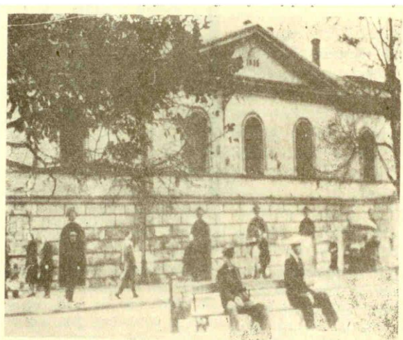
Ryc. 21. Nieistniejący już Szpital Panny Marii w Częstochowie, jedno z miejsc
